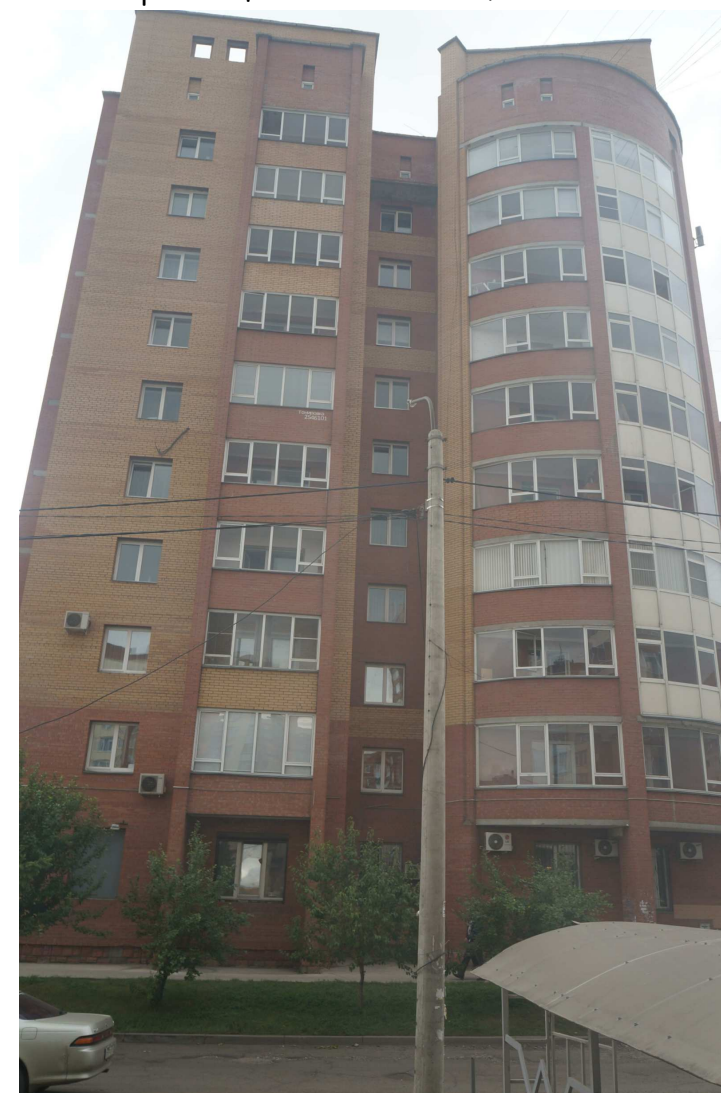
Фотофиксация бокового (юго-восточного) фасада
