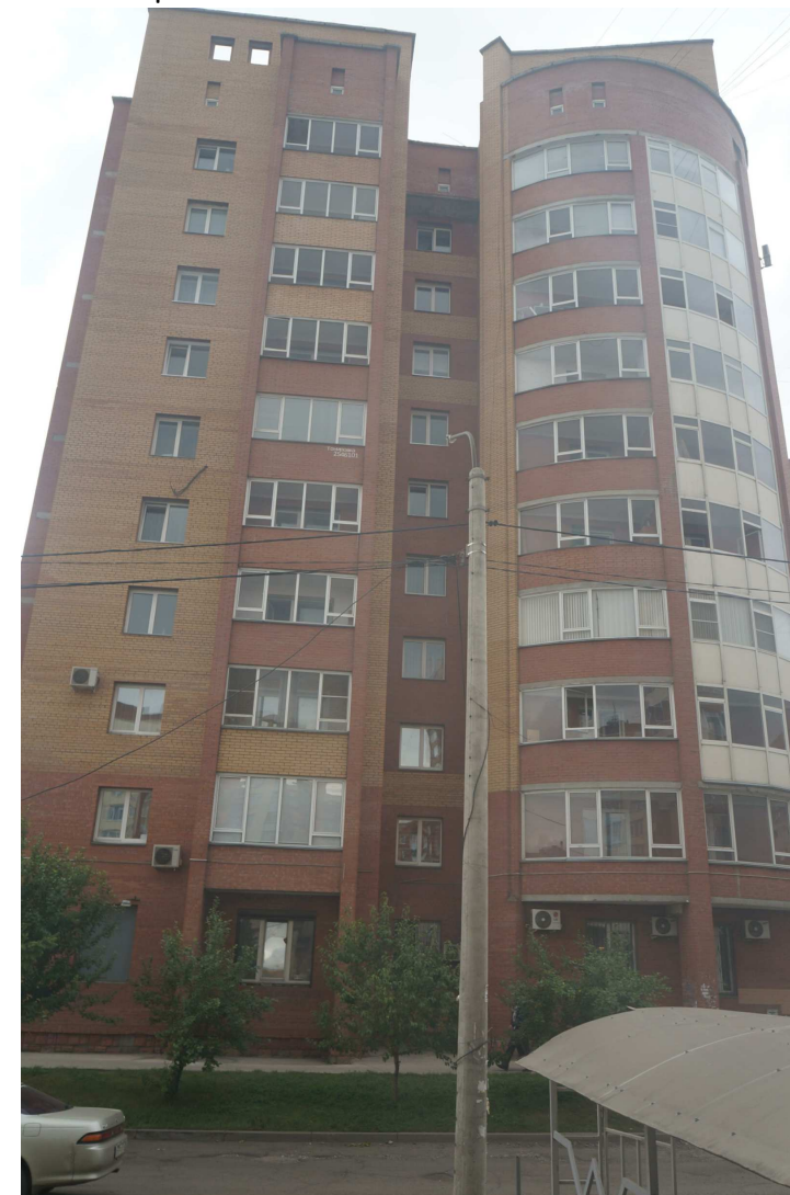
Фотофиксация бокового (юго-восточного) фасада
