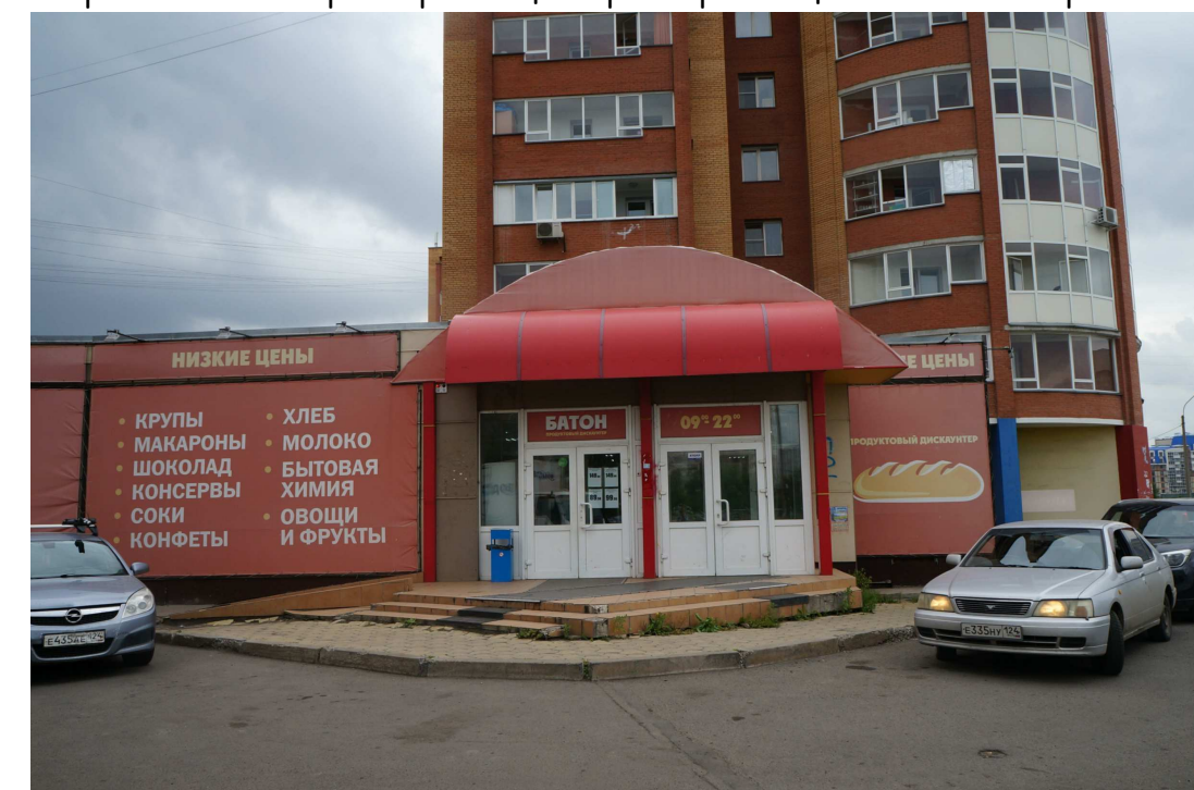
Фрагменты 4 фотофиксация бокового фасада
