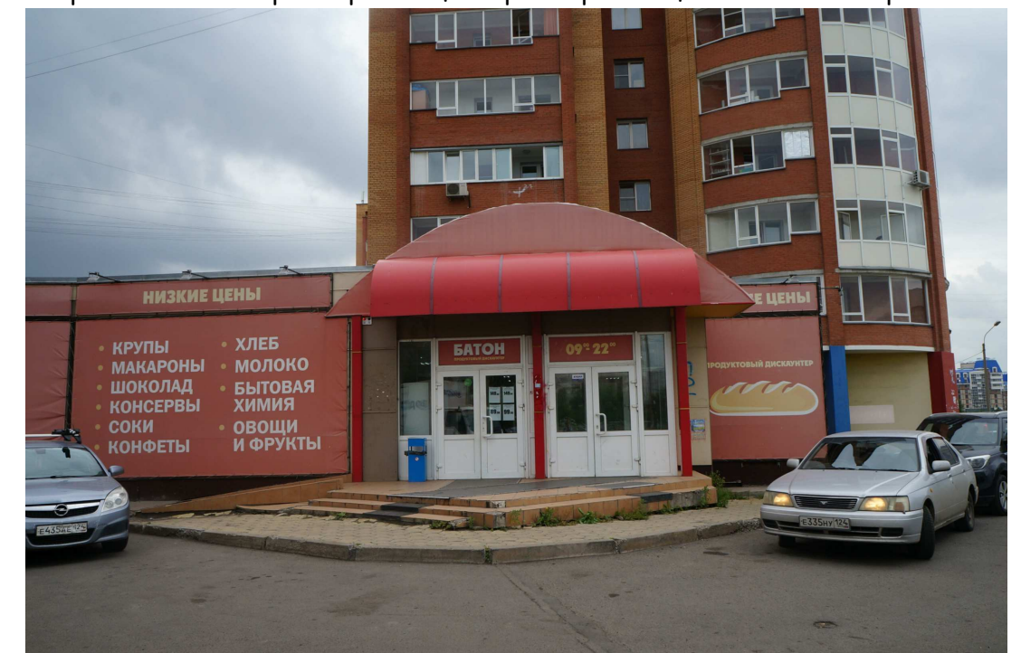
Фрагменты 4 фотофиксация бокового фасада
